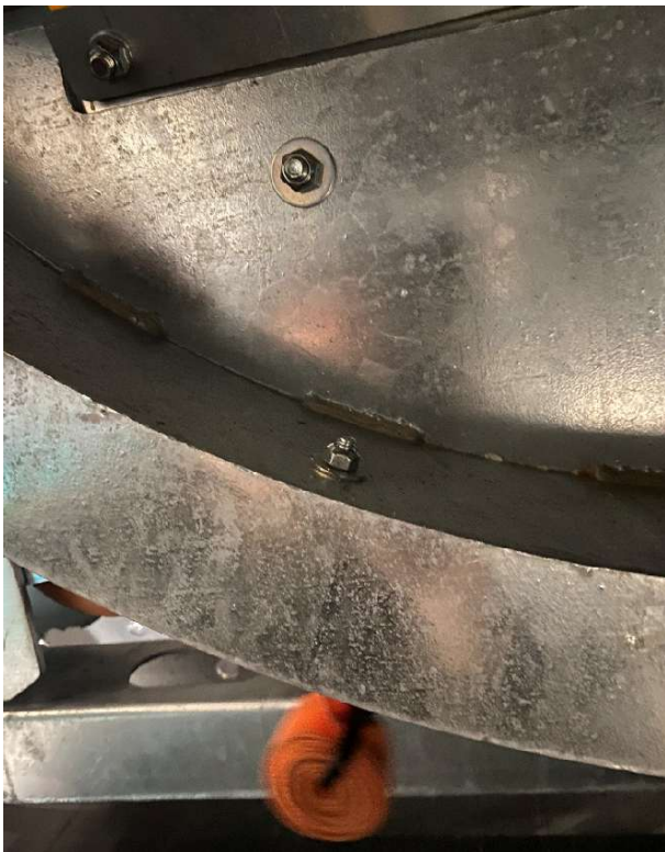
Abb. 7: Fertig montierte Dichtmanschette - Detail Befestigung
